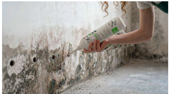
Einsatz der Injektionsflaschen
