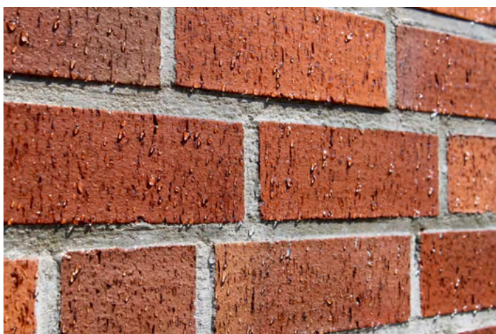
Abb.2 Imprägnierte Fassade. Wasser perlt ab und der Baustoff ist trocken.
