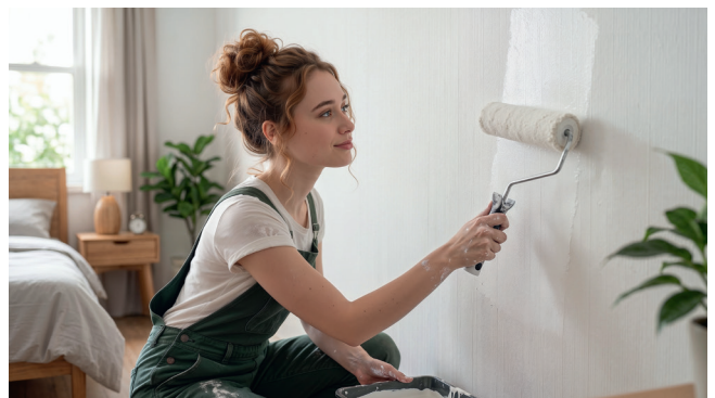
Auftrag von NovuProtect
