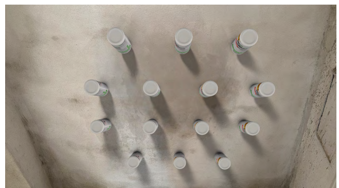
Ausführung partielle Flächensperre
