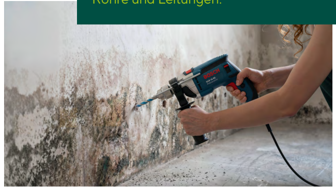
Bohrung im 45° Winkel
